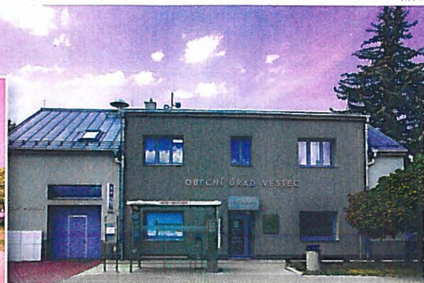
V roce 2015 se ve Vestci dočkala rekonstrukce budova obecního úřadu.
