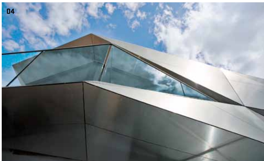
04 > Konstruktivně je střecha navržena jako lehký montovaný celek s nosným ocelovým skeletem
