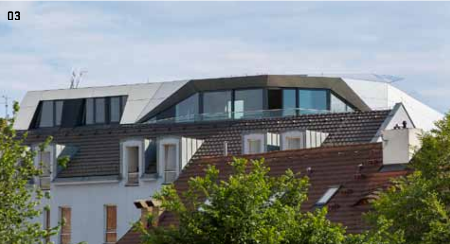
03 > Okna posledního podlaží jsou otočena směrem od náměstí
